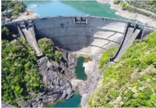
(一ツ瀬ダム全景)
